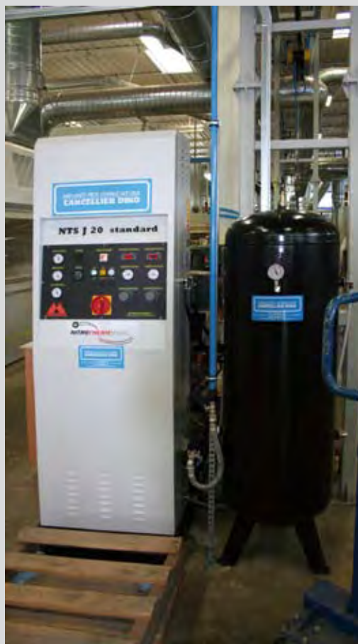
A - L'apparecchiatura di produzione dell'azoto, derivato dall'aria captata nell'ambiente. A destra, il contenitore dell'azoto prodotto. A - L'apparecchiatura di produzione dell'azoto, derivato dall'aria captata nell'ambiente. A destra, il contenitore dell'azoto prodotto.
