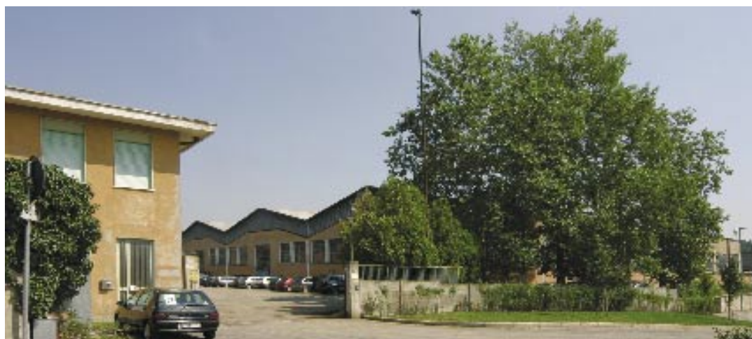
Fig. 2 - La sede della Fabesc a Cortenuova di Monticello Brianza (Lc).
