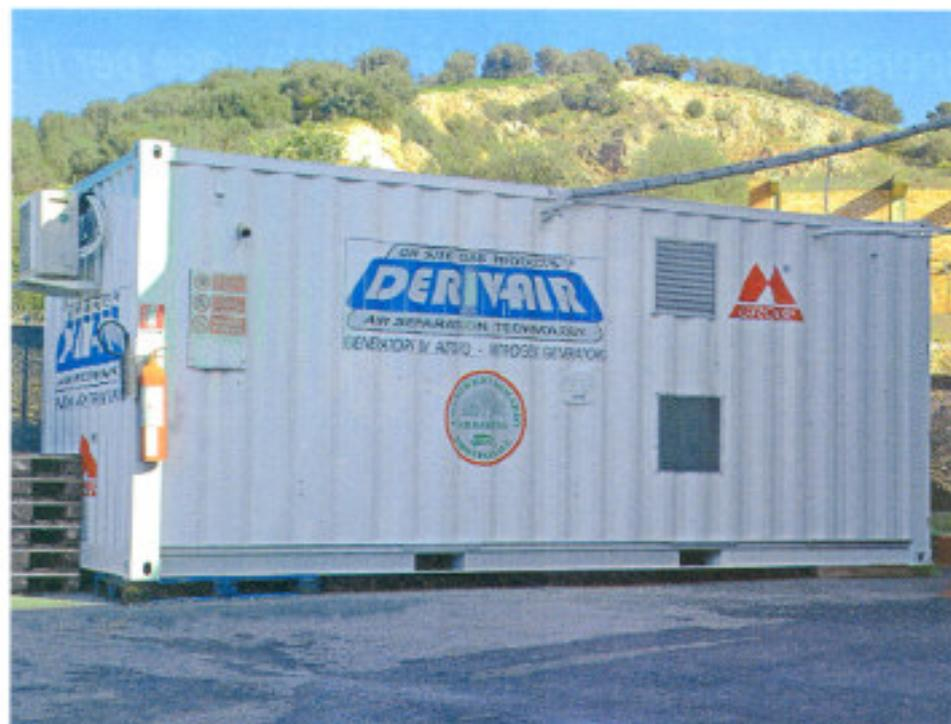
Container all'interno del quale è stato installato il generatore d'azoto impiegato nel trattamento del grano insilato
