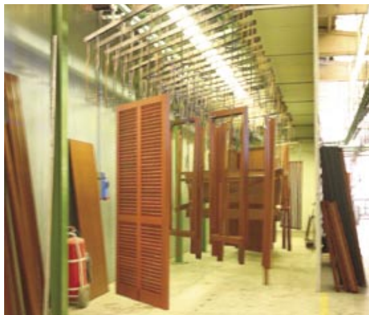
1 - Interno del tunnel d'essiccazione dell'impianto dedicato ai serramenti.
